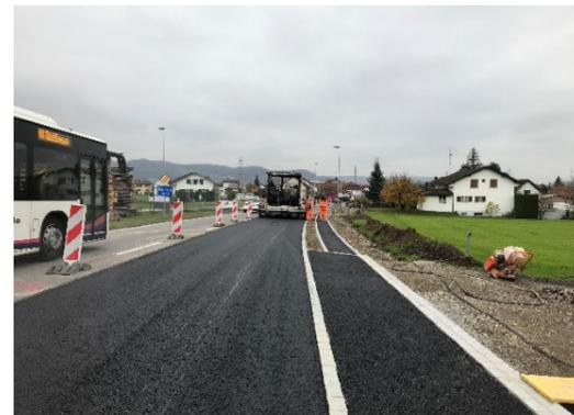
Belagseinbau Tragschicht und Einsatz Belagsfräse
