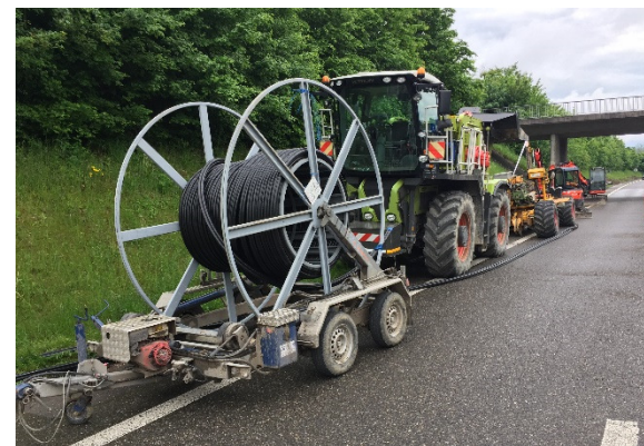
Maschinenkolonne für die Pflügarbeiten
