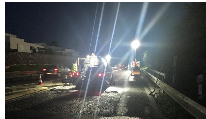
Nachtsperrungen und -arbeiten während Belagssanierungen
