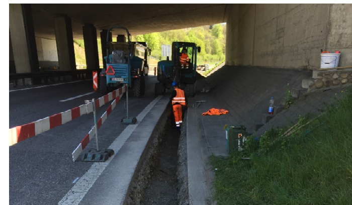
Konventionelle Verlegung im Belag des Standstreifens
