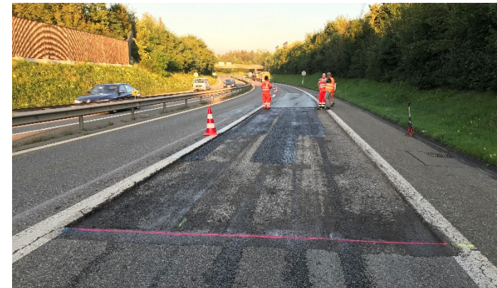
Stellenweise Belagssanierungen
