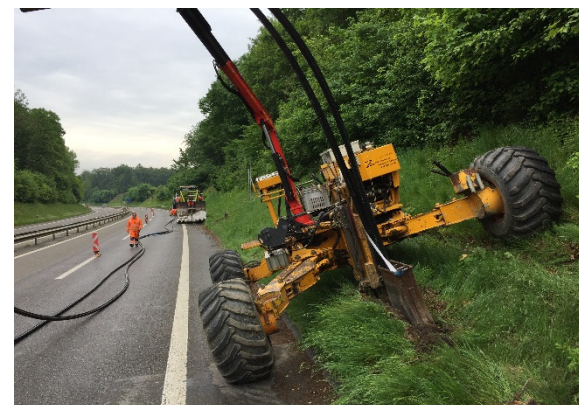
Einpflügen der Multirohre
