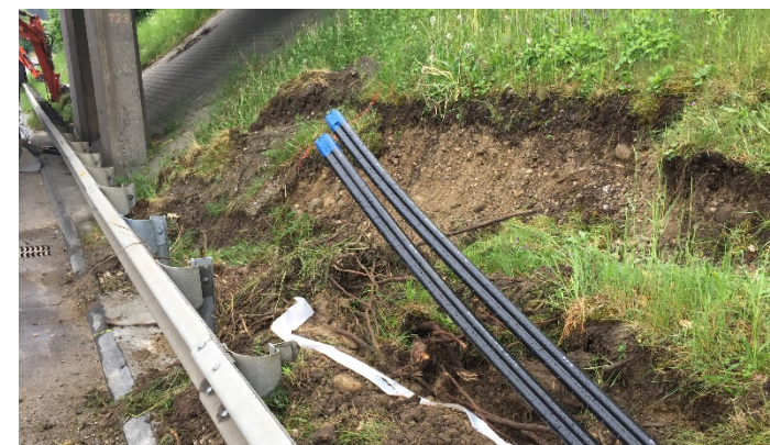
Übergangsbereich Pflügen zu konventionellem Verlegen
