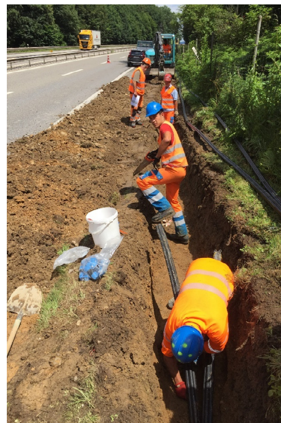
Konventionelle Verlegearbeiten
