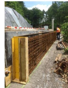
Böschungssicherung mit Mikropfählen
