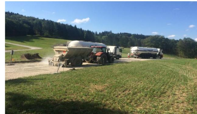
Aufbringen des Zements für die Stabilisierung
