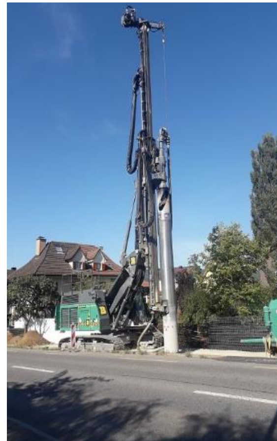
Bohrgerät für Pfähle d=600mm, Länge 4.0 – 6.0 m
