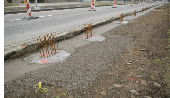
Anschlussarmierung Bohrpfähle
