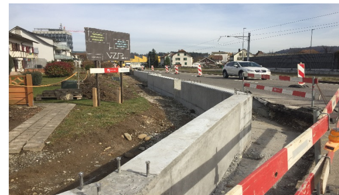
Sockelmauer mit Staifix-Anschluss für Stahlstützen
