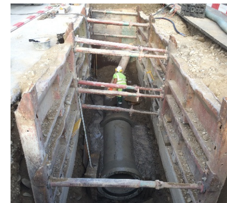
Baugrube Tiefe 4.5m
