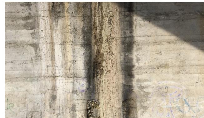
Erste Betonabplatzungen am Fuss des westlichen Brückenbogens
