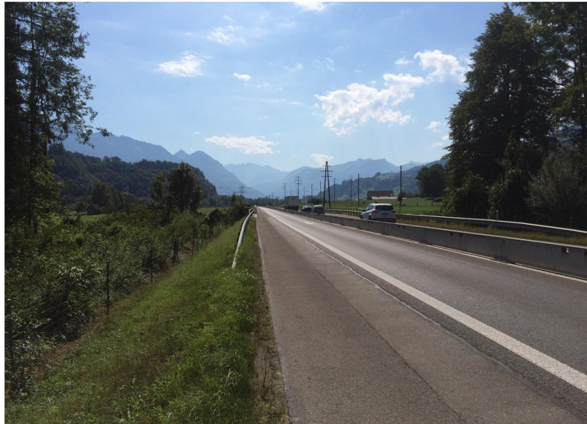
Blick Richtung Sarnen mit der bestehenden Richtungstrennung mittels Wallstop-System im Mittelstreifen
